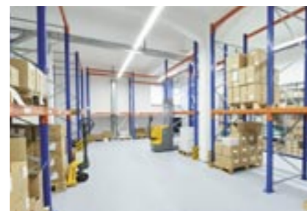
Der Boden ist direkt nach der Verlegung wieder befahrbar
